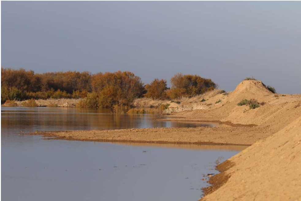
Figura 2. Coronación de penínsulas emergidas sobre la mota Norte en Horcada1 antes de finalizar los vertidos (Autor: R. Muriel, EBD-CSIC).
