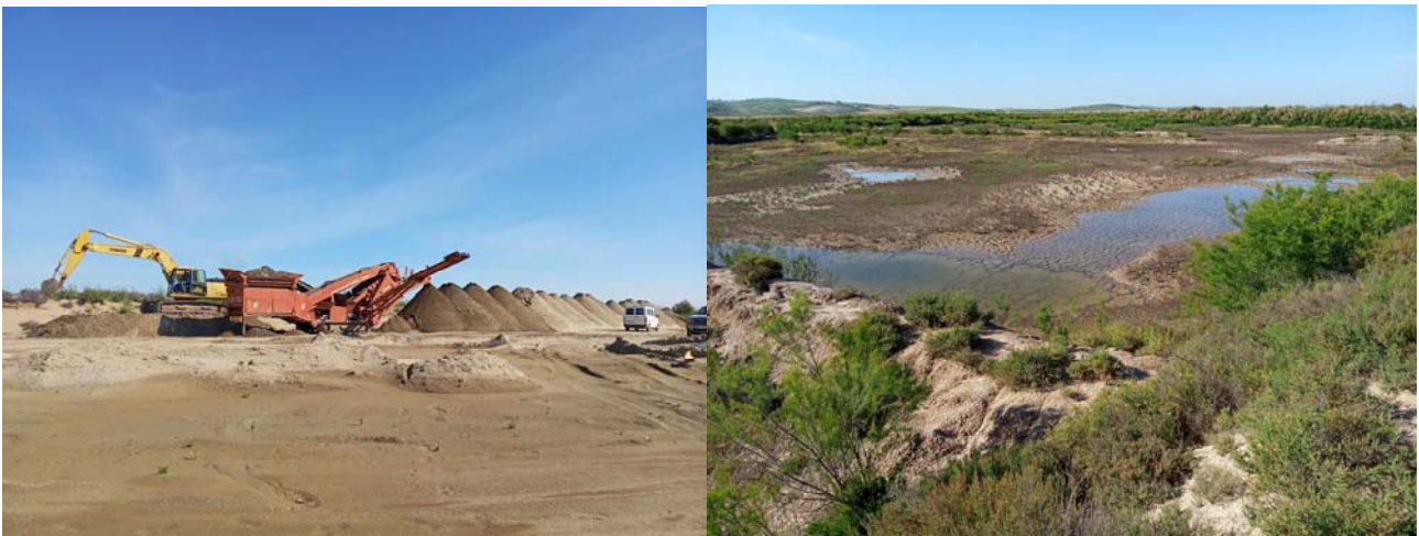
Fotografía 8. Maquinaria de extracción y clasificación de áridos trabajando en el lado noreste de Yeso1 durante la campaña 2019-20 (izquierda). Pequeñas láminas de agua marginales formadas por la acumulación de precipitaciones a principio de mayo de 2020 en el subsector este de Yeso2 (derecha) (Autor: R. Muriel, EBD-CSIC).
