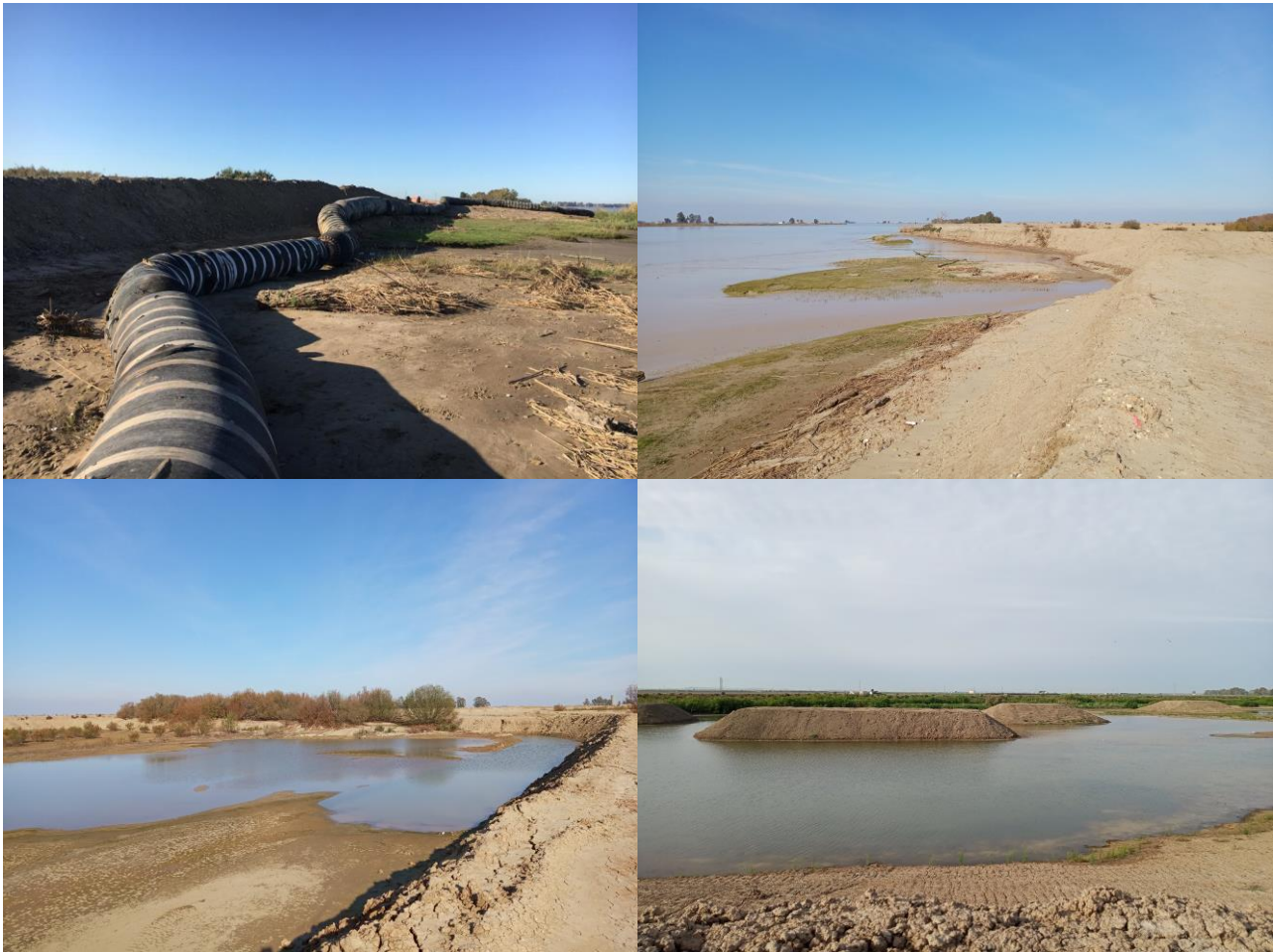
Fotografía 7. Conducción de vertido sobre el borde oeste de Horcada2 a mediados de septiembre de 2019 (arriba izquierda); panorámica de la orilla del río Guadalquivir y lado oeste de Horcada2 con marea alta a mediados de febrero de 2020 (arriba derecha); lámina de agua residual en subsector norte de Horcada2 procedente del vertido destinado a Horcada1 a mediados de febrero de 2020 (abajo izquierda); estado post-vertido de las islas artificiales en Horcada1, con una gran diferencia entre la cota de coronación y la superficie del agua debido al bajo nivel de inundación (abajo derecha) (Autor: R.Muriel, EBD-CSIC).
