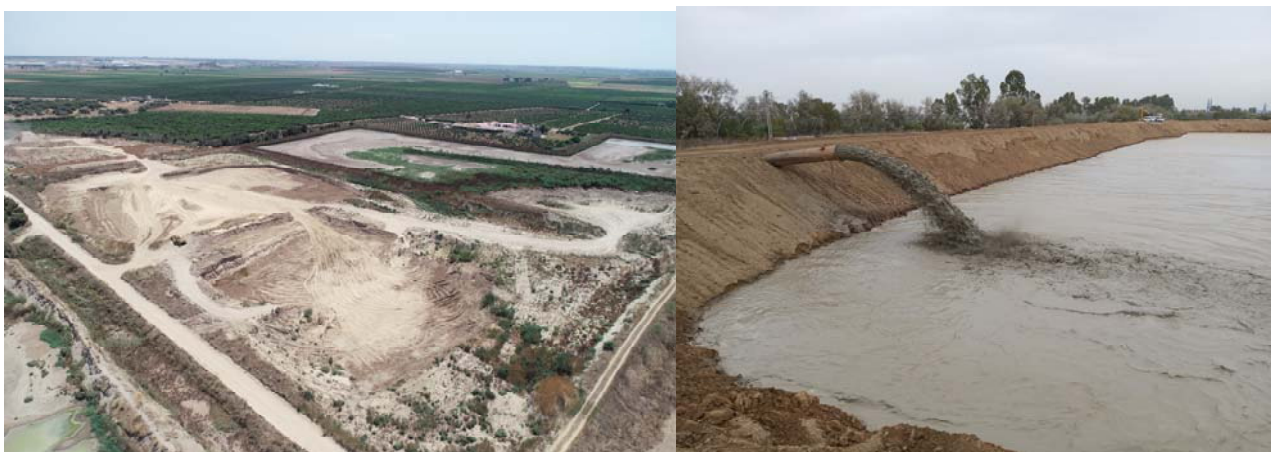
Fotografía 4. Aspecto del sector de Butnao3N en agosto de 2020 antes de los trabajos de adecuación previos al vertido (izquierda) y vertido de materiales de dragado en la zona de impulsión del lado NO de Butano3N en noviembre de 2020 (derecha) (Autores: M. Barbero, AerialRotors; R. Muriel, EBD-CSIC; APS).
