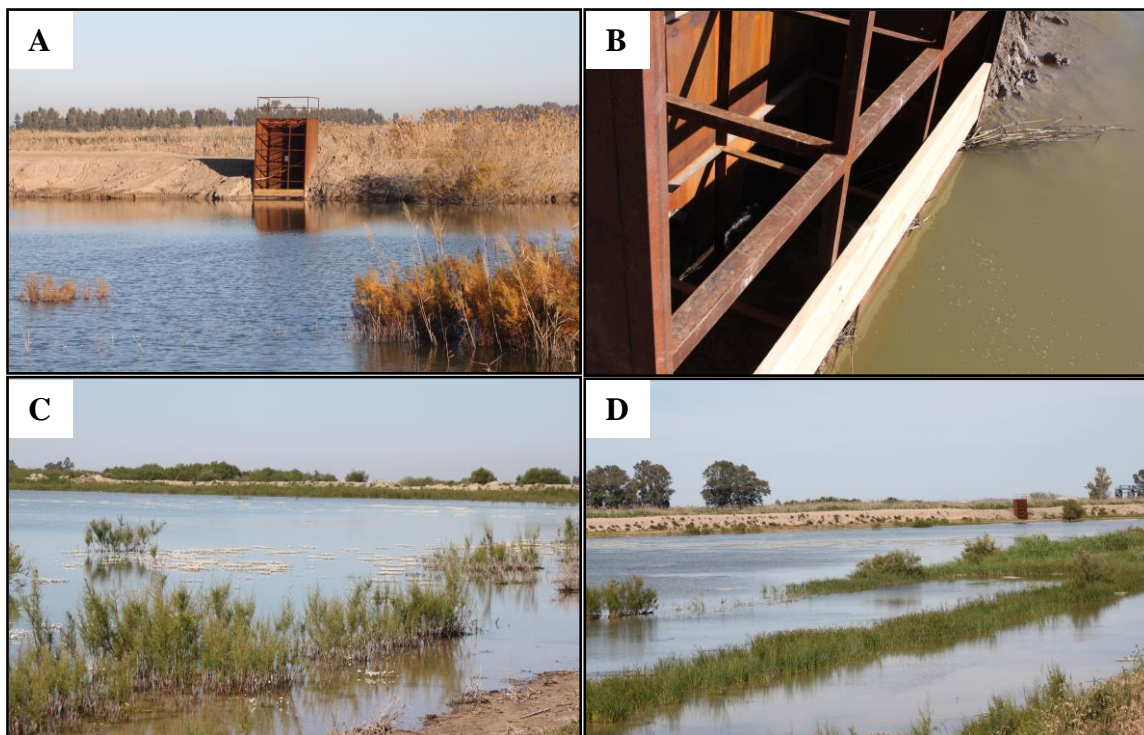
Figura 26. Vista de la compuerta de desagüe o “caja de agua” instalada en La Horcada (A) para regular el nivel de inundación del vaciadero (B). Aspecto del sector A del vaciadero de La Horcada tras haber mantenido la lámina de agua durante la primavera de 2017 (C-D). (Fotos: Javier Manzano)
