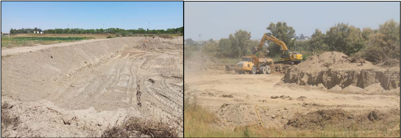
Fotografía 51. Extracción de materiales y remodelación completa de la mota perimetral en el lado NE (izquierda), y extracción de materiales en curso en el frente de los acopios de materiales antiguos cubiertos por tarajal maduro (derecha), en el sector Butano1 desde el mes de mayo de 2020 (Autor: R. Muriel, EBD-CSIC).
