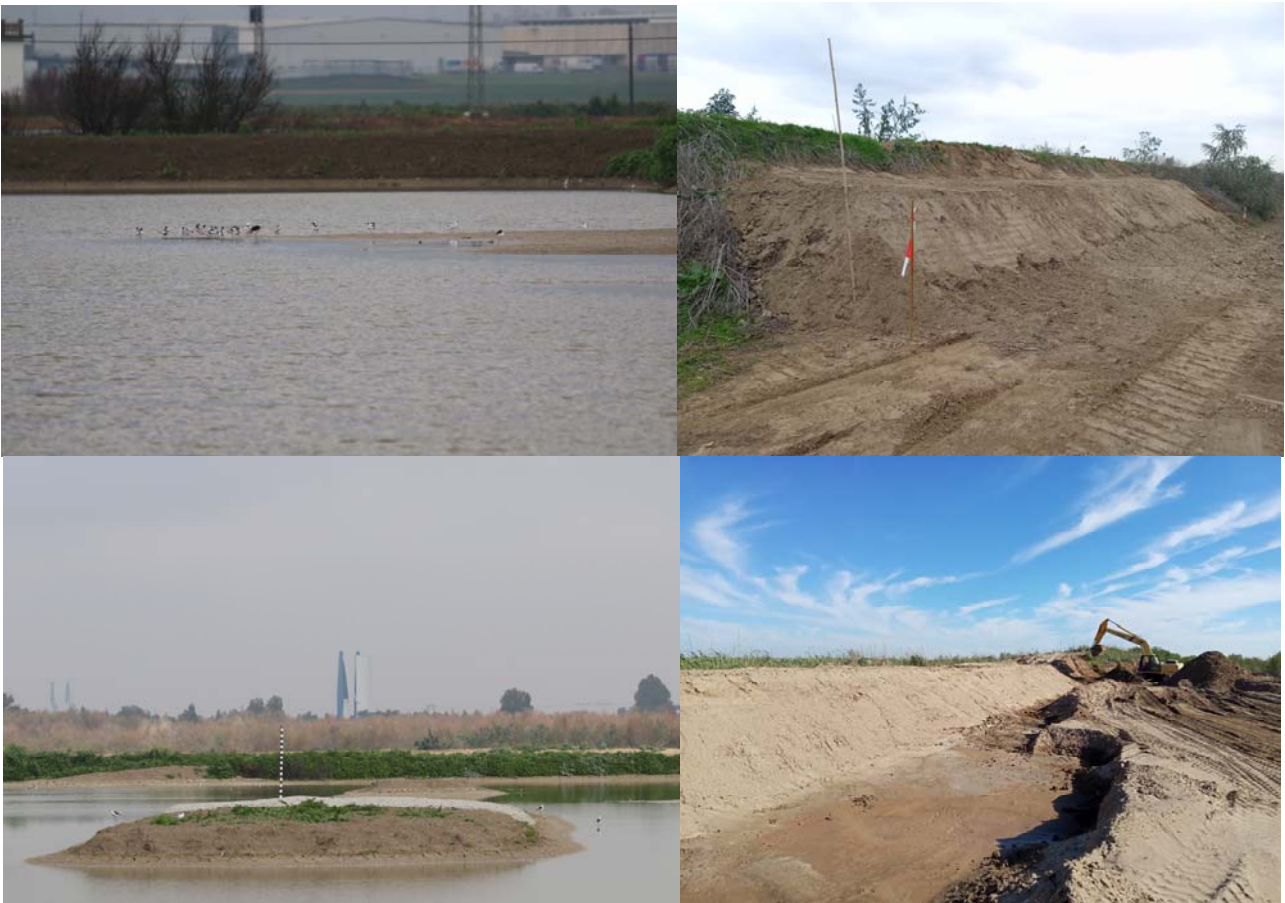
Fotografía 1. Actuaciones y trabajos realizados en la adecuación de los vaciaderos terrestres en la presente campaña 2020-21: bando de avoceta común ( Recurvirostra avosetta ) y cigüeñuela común ( Himantopus himantopus ) sobre una de las penínsulas construidas en Butano3S (arriba izquierda); talud para abejaruco europeo ( Merops apiaster ) sobre seco en la cara exterior de la mota NO de Butano2 (arriba derecha); isla artificial con la mitad de la superficie cubierta de grava en Butano3S (abajo izquierda); reperfilado de mota perimetral y eliminación de la vegetación desarrollada sobre el talud en el Yeso1 (abajo derecha) (Autor: R. Muriel, EBD-CSIC; APS).
