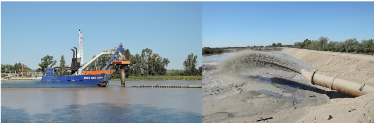
Fotografía 4. Descarga desde la draga de materiales dragados del fondo del río Guadalquivir a través de la conducción de vertido (izquierda) e impulsión en el sector de Butano3S (derecha) a principios del mes de octubre de 2019 (Autor: R. Muriel, EBD-CSIC)..
