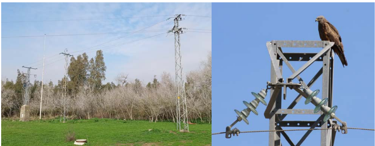
Fotografía 46. Tres de los apoyos más peligrosos del tendido eléctrico de distribución en Butano1, con diseño de amarre con o sin seccionadores o puentes por arriba (derecha). Milano negro ( Milvus migrans ) posado sobre apoyo tipo tresbolillo no peligroso en el entorno del río Guadalquivir a principios de marzo (derecha) (Autor: R. Muriel, EBD-CSIC).
