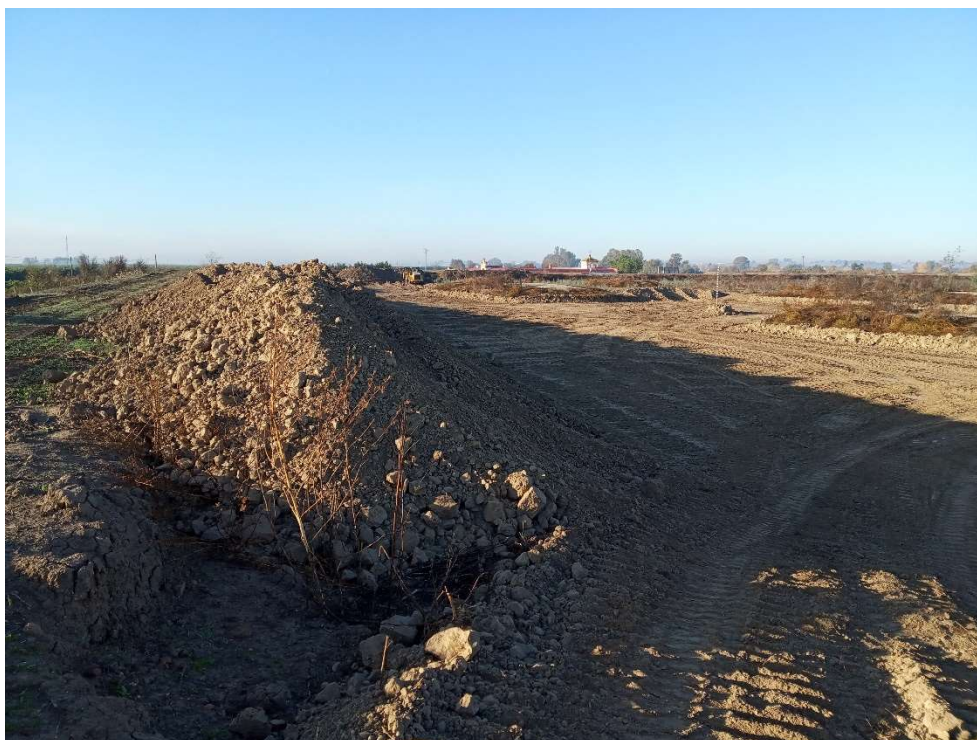
Figura 5. Acopio de materiales sobre cara interior de la mota perimetral SE, retirados del fondo entorno a las islas del subsector Sur de Butano3S. Vista desde esquina SE (Autor: R. Muriel, EBD-CSIC).
