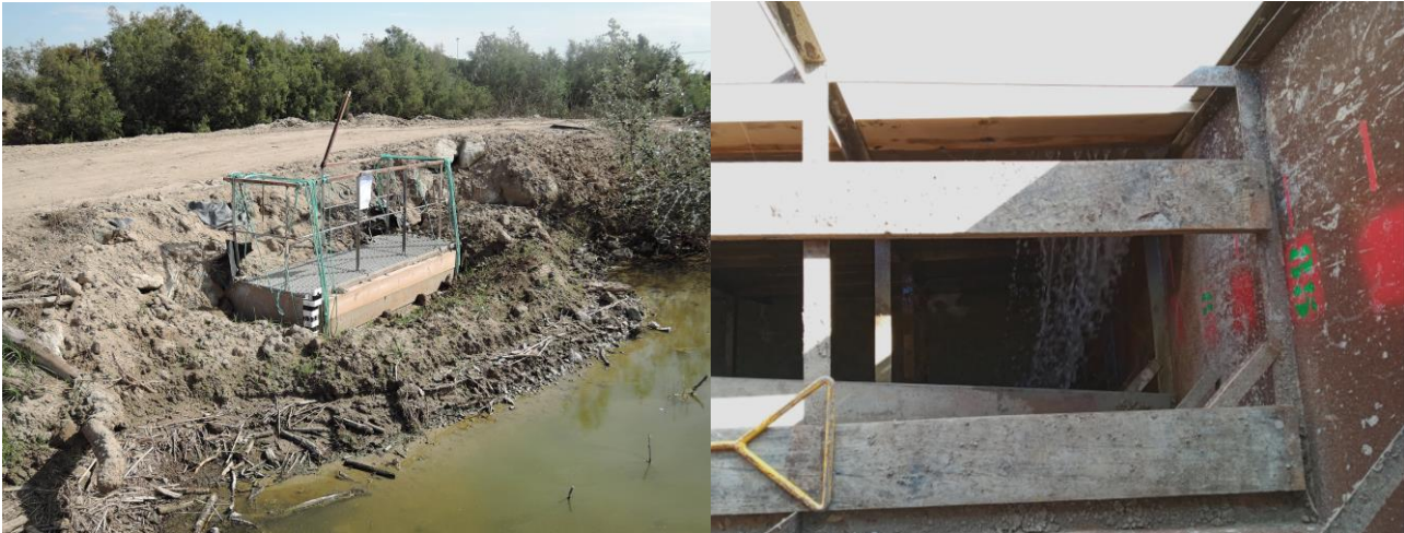
Fotografía 6. Aspecto de la caja de agua en Butano2 una vez sellado el frente con el acopio de materiales por encima del nivel máximo previsto del agua (izquierda). Se observa la parte superior de la escala limnimétrica pintada sobre el perfil metálico en la esquina de la caja. Detalle de la filtración de agua entre las tablas de la caja de agua de Butano3S a principios de noviembre (derecha) (Autor: R. Muriel, EBD-CSIC).
